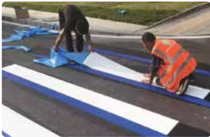
Fig. 473/C 3G-reflective pavement tape (attraversamenti pedonali) cm. 50x35 ml.
